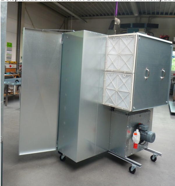
Beispielbild Rückseite HK-Baureihe mit Aktivkohlpatronen-Filtersystem
